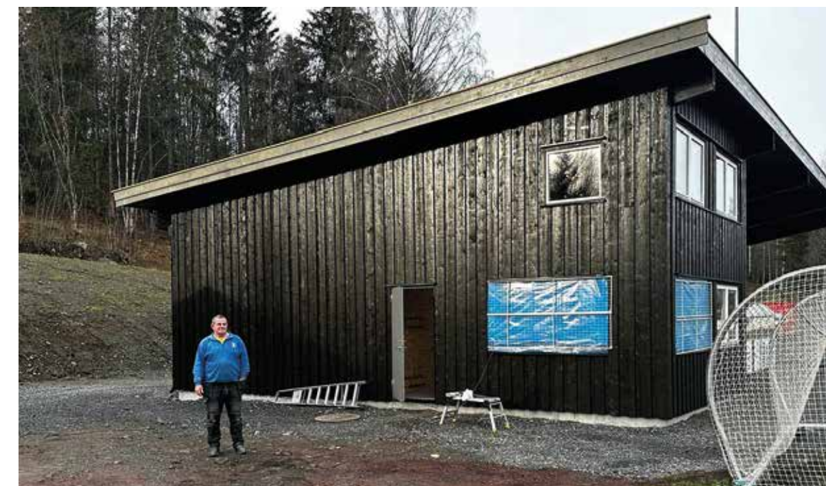
SNART FERDIG: Noen få dager igjen, så er det nye bygget ferdig. – Det kommer elever fra Vargstad videregående skole som skal legge opp det elektriske anlegget, sier Roger Sletten.
