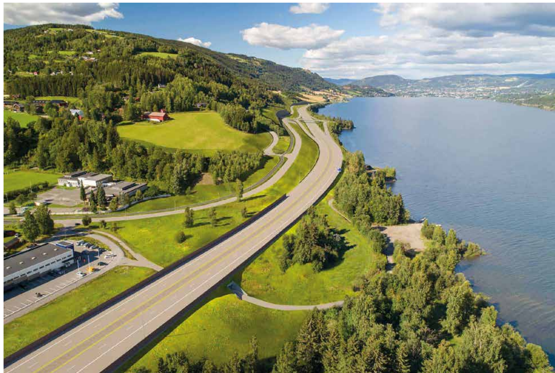
VINGROMKRYSET NORD: Krysset på Vingrom flyttes noen hundre meter nordover. Dette frigjør plass i Vingrom sentrum. Vi oppnår også bedre støyskjerming for boligbebyggelsen, og det gir mer areal til friluftsområdet ved Mjøsa. (Illustrasjon: Nye Veier/Norconsult)
