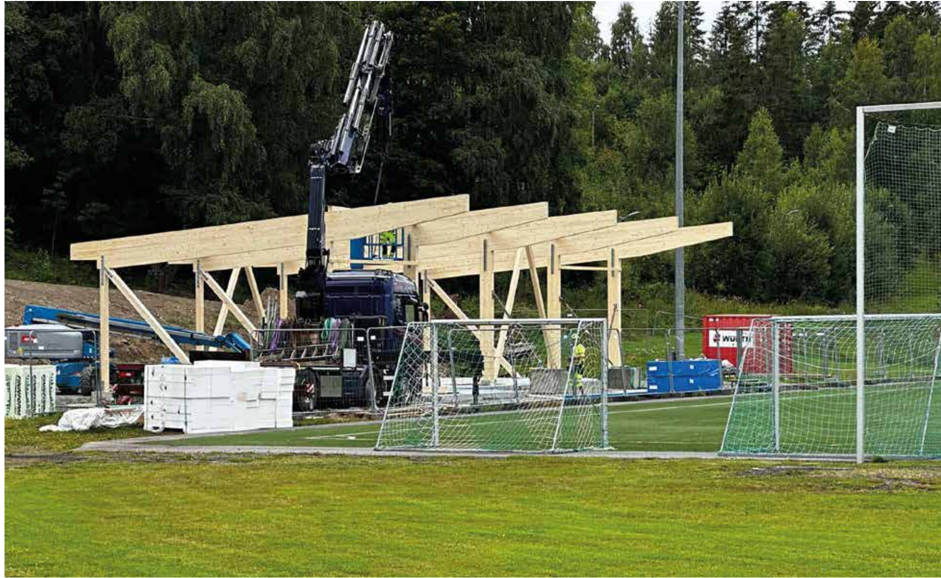
NYBYGG: Det nye lagerbygget er i ferd med å reise seg.
