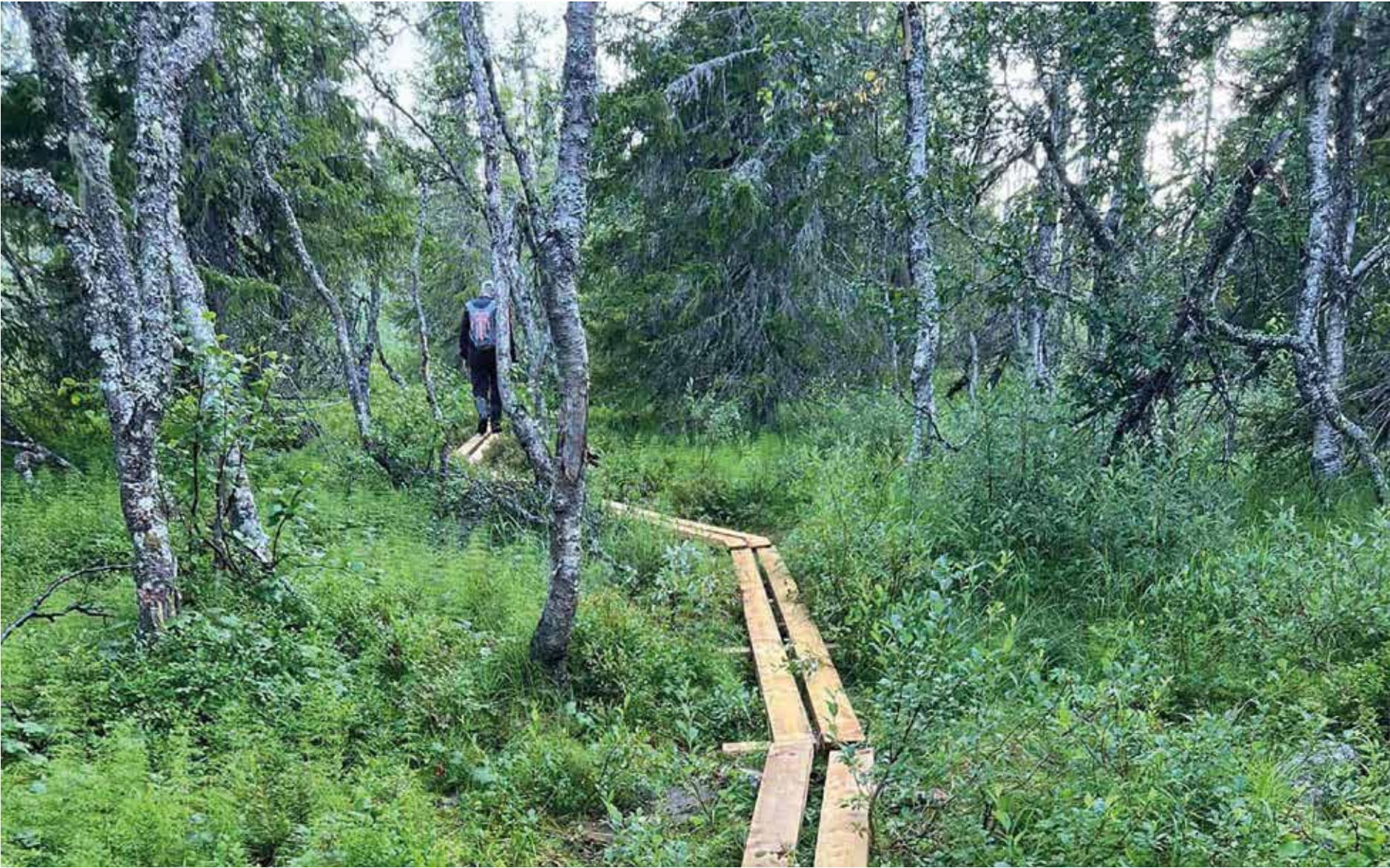
PLANK: Arbeidet med å legge plank i stien er allerede i gang.
