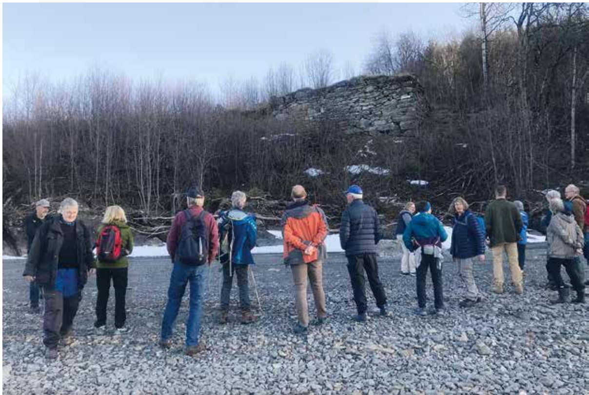
GRUNNMUR: En svært imponerende grunnmur holder fortsatt stand på Kremmerodden.
