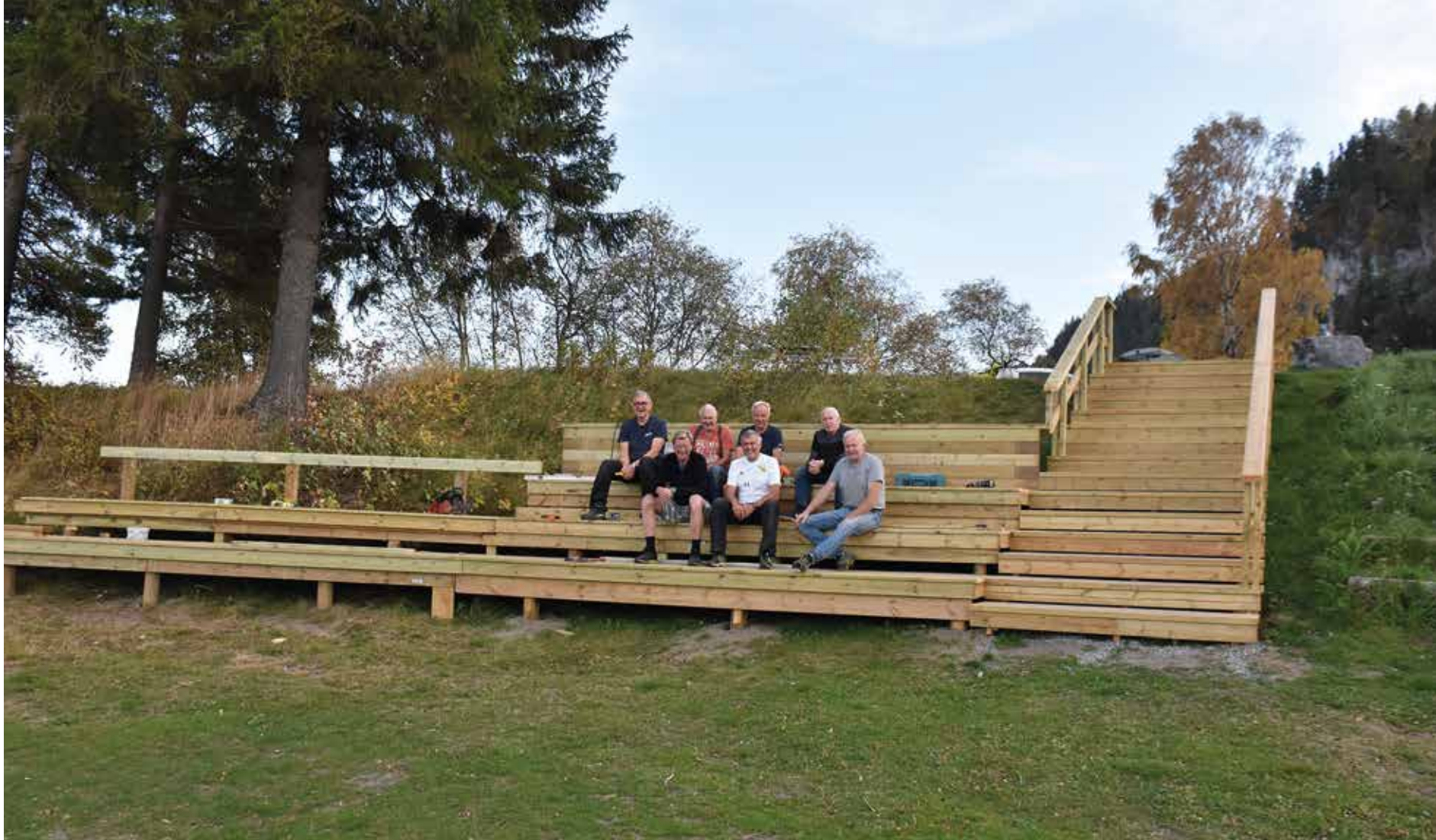
AMFI og TRAPP: Et amfi og ny trapp er straks ferdig. Vel 40 personer kan sitte på amfiet. Den gamle trappen skal fjernes.
